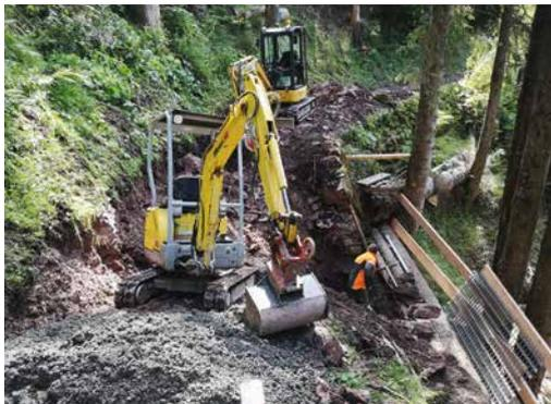
Es wurden wieder einige Unterhaltsarbeiten getätigt und erledigt. So mussten die Sturmschäden an den Verbindungsstrassen zum Neubruch – Solen und Solen - Tobelwald aufgeräumt und die Strassen an gewissen Stellen repariert werden.
