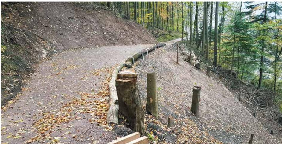
Sitenstudewald, frisch erstellte Böschung hinter der Stahllarsenwand sowie frisch eingekiester Weg
