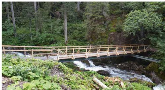
Durch den jährlichen winterlichen Schneedruck wurden die tragenden Holzstämme an einigen Stellen faul oder waren bereits gebrochen. Somit musste aus sicherheitstechnischen Gründen die Wanderwegbrücke Bachlaur – Gspen ersetzt werden.
